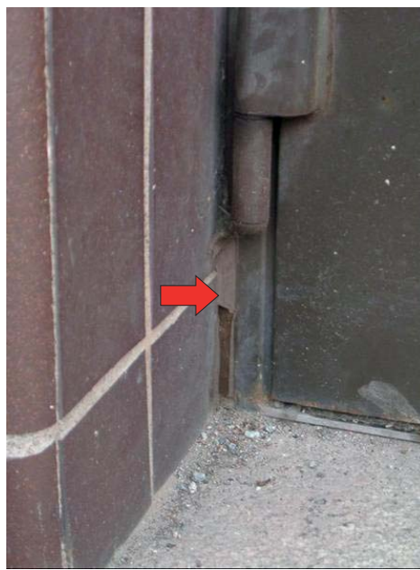
Fogmassa vid ställlucka
