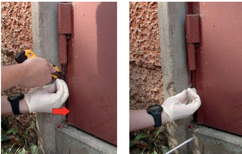
Fogmassa skärs ut. Bara handen med plasthandske får beröra fogmassan.
