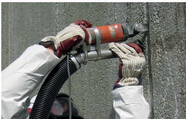
Saneraren använder en äldre modell av kniv från Fein.
