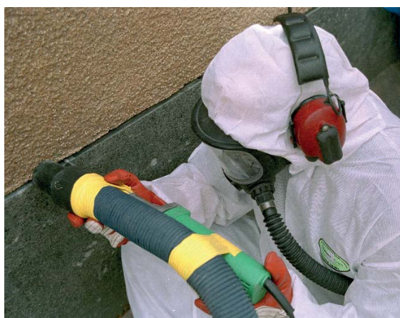
Slipning med slipstift och dammuppsamling nära verktyget.
